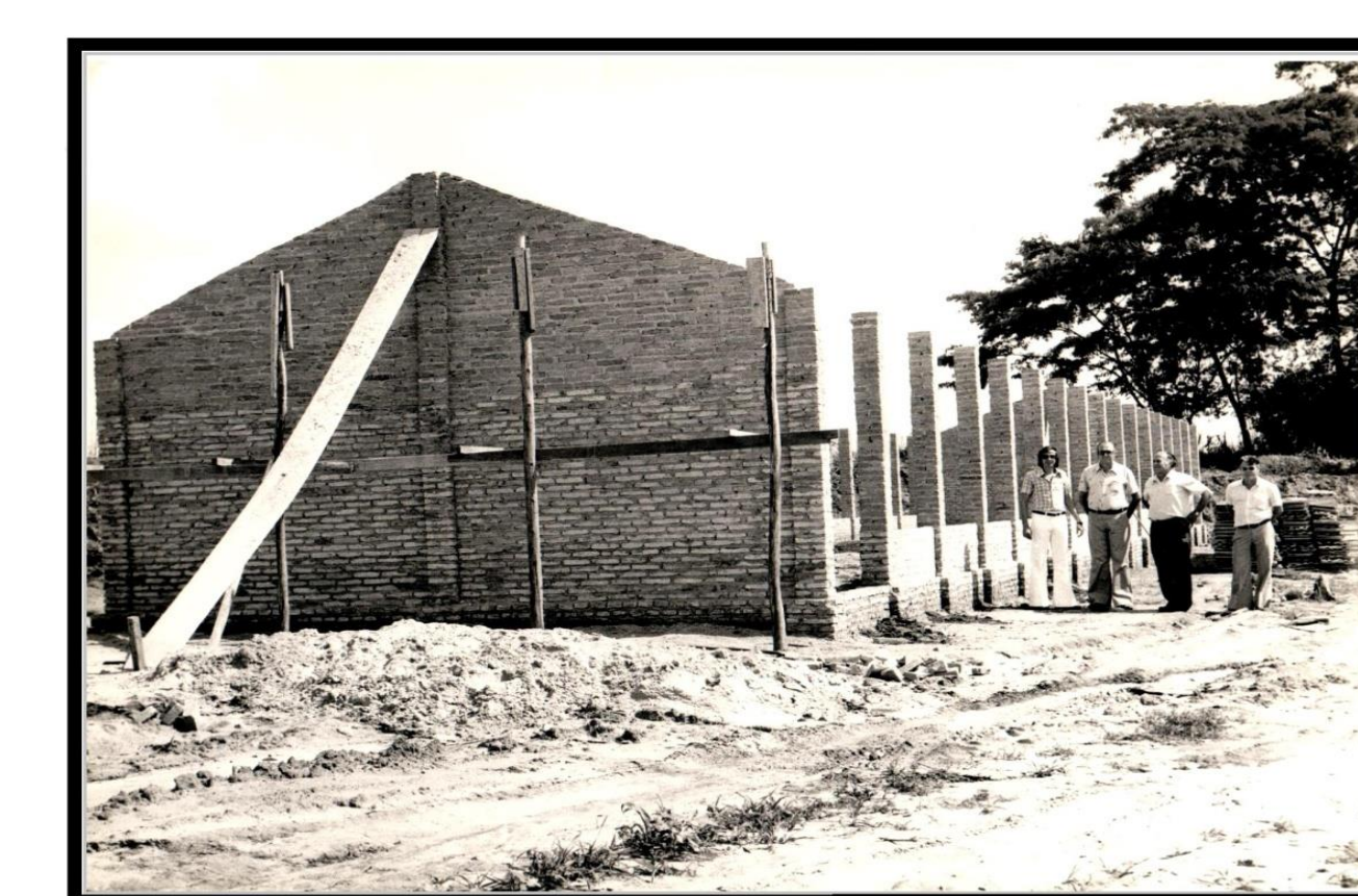
Figura 5: Construção de duas salas de aula – Nozor de Arruda Cardoso, o diretor Antônio Ferdinando Francisco Possebon, o vice-prefeito Elias Thomé e o motorista da prefeitura. . Fonte: Acervo Antônio Ferdinando Francisco Possebon.
