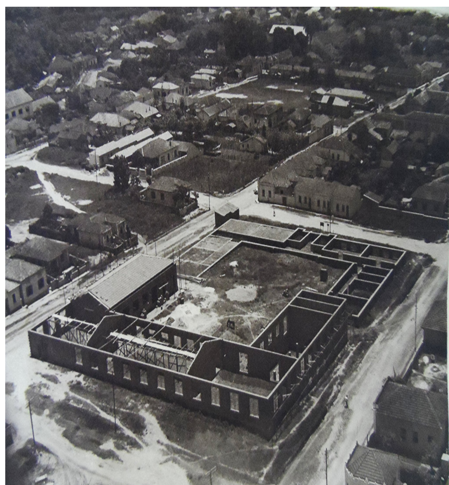
Figura1 - Obras da construção da Escola Industrial Trajano Camargo. Fotografia: José Rodolpho Rodrigues. Acervo Museu Histórico e Pedagógico Major José Levy Sobrinho. Limeira-SP.
