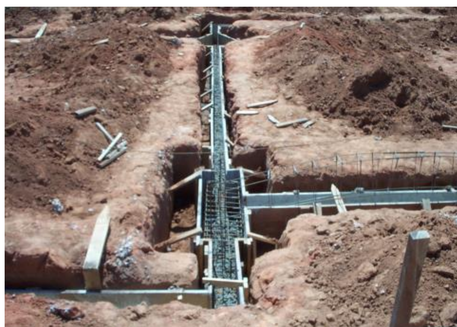
Figura 1: Alicerce o da construção do primeiro prédio.
