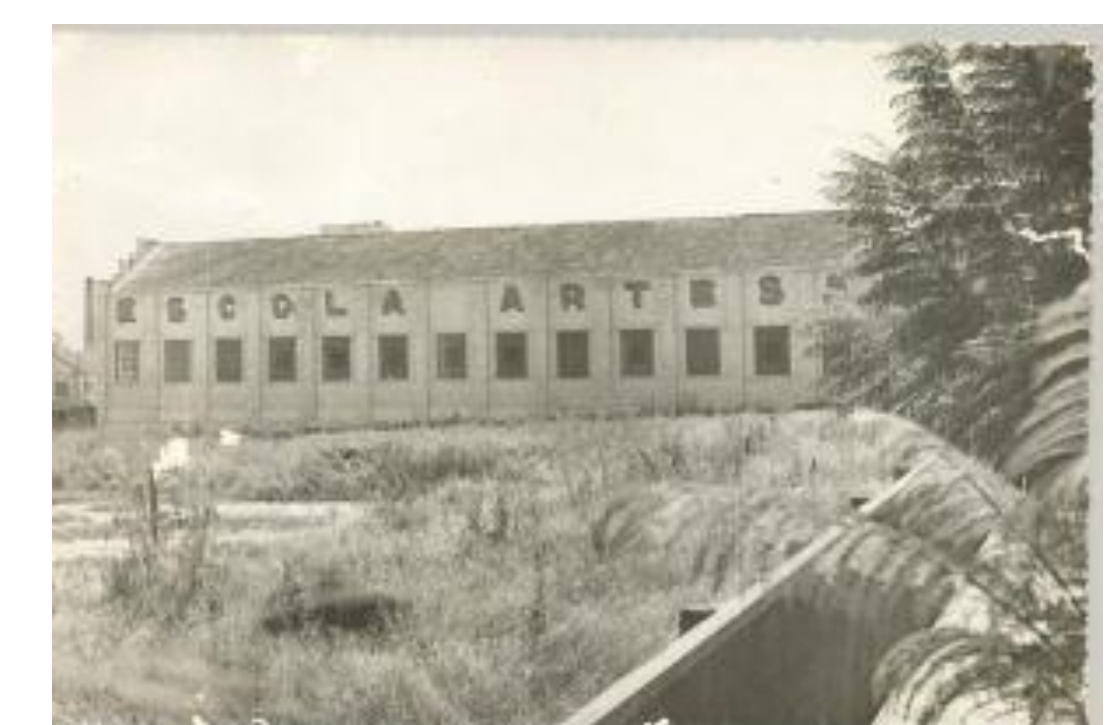
Figura 6- Fachada do prédio inicial da Unidade Escolar.
