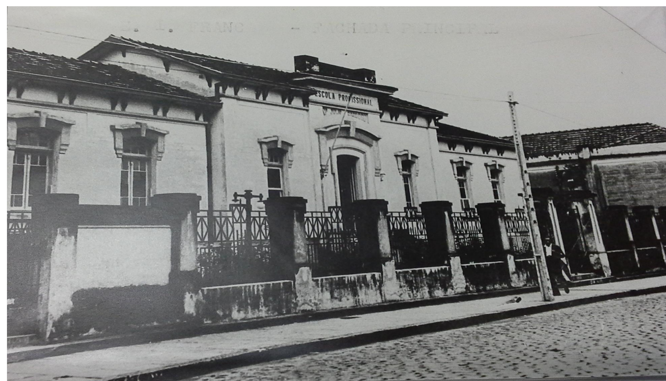
Figura 1- Fachada da Etec Dr. Júlio Cardoso – 1955 Fonte: Acervo do Centro de Memória da Etec Etec Dr. Júlio Cardoso , em 2015.
