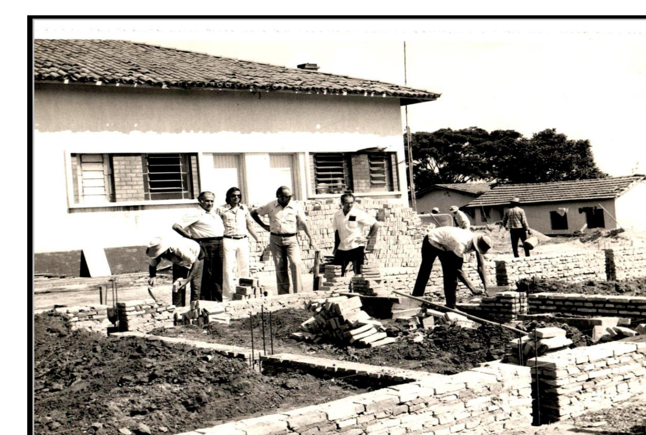
Figura 4: Construção de duas salas de aula – vice-prefeito Elias Thomé, Nozor de Arruda Cardoso, o diretor Antônio Ferdinando Francisco Possebon e o professor Nildo Morseli. . Fonte: Acervo Antônio Ferdinando Francisco Possebon.
