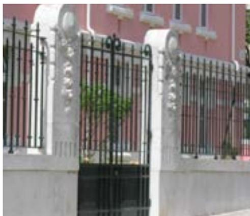
**Figura 12** - Gradeamento em ferro e portão lateral da fachada principal
